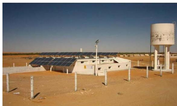
图 14 突尼斯光伏反渗透海水淡化系统
