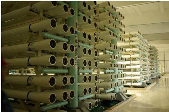
图 15 华能玉环电厂 3.5 万吨/日 SWRO 装置
